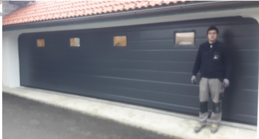
Avtomatska garažna vrata dim. 9m x 2m.
